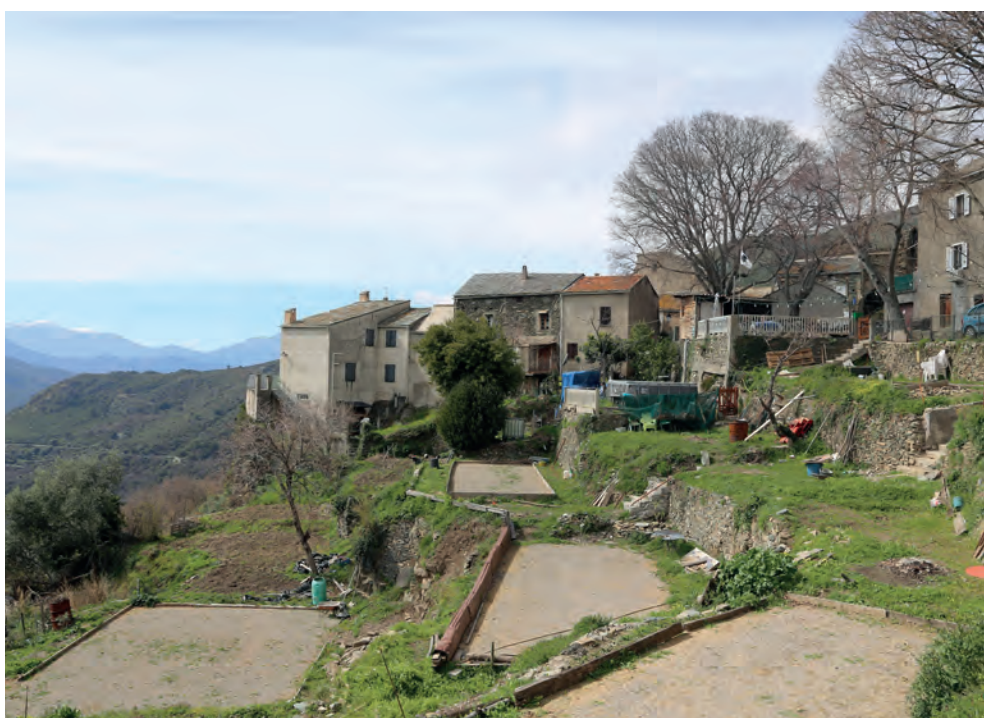
Vue des terrasses, avant intervention
