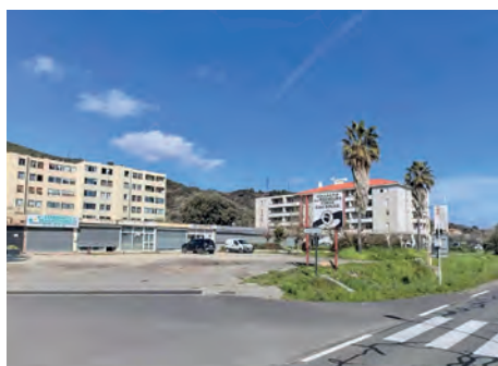
(3) Photo depuis le sud du site de projet
