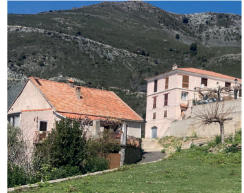
Toiture en tuiles Bigorno
