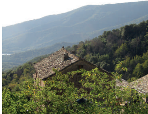
Toiture en lauzes Vignale
