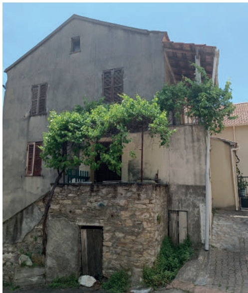
Terrasse en plein, pergolas végétalisée qui assure la continuité du bâti
