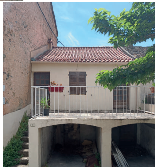
Terrasse sur pilotis qui crée des vides qui ne respectent pas le contexte . Pas de pergolas, non usage de matériaux locaux.
