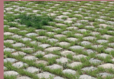
Stabilisé en calcaire
