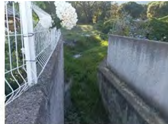
Ouvrage en amont du passage en souterrain du Ficabruna
