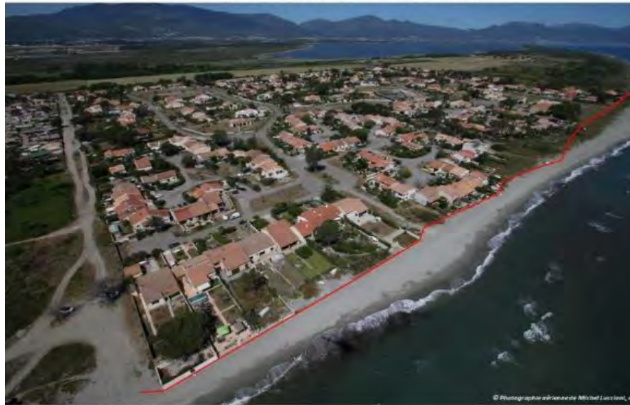
Lotissement Maraninca, commune de Lucciana
