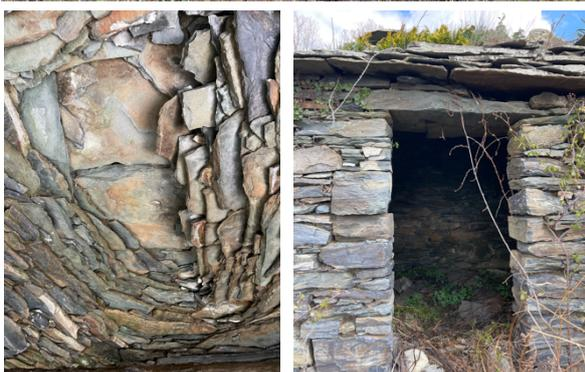
A quelques centaines de mètres du sentier se trouve ce magnifique *pagliaghju* en très bon état. Son toit en encorbellement a plusieurs noms en corse, *à volta*, *fattu à fornu*, *à loghja*. Celui présent sur la photo risque un jour ou l'autre de s'écrouler s'il n'est pas entretenu. Les plantes, poussant entre les lauzes, fragilisent le toit et participent à sa détérioration.
