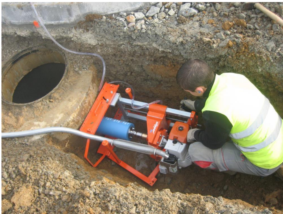
Carottage du regard existant ou créé
