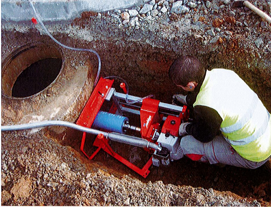
Carottage du regard existant ou créé
