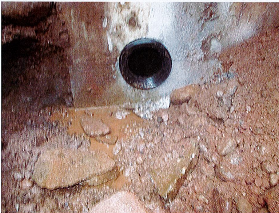
Mise en place du joint Forsheda prêt à recevoir le tuyau
